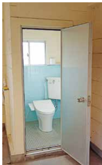
温水洗浄便座付き洋便器の トイレに取り替えられた
