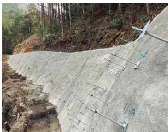
モルタル吹付・鉄筋挿入工
